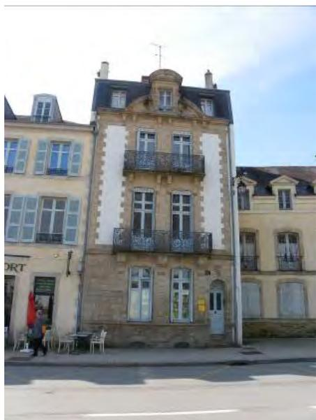
24, rue du Port. Maçonnerie en pierre de taille en rez-de-chaussée, maçonnerie mixte aux étages. Fin du 19<sup>e</sup> siècle.
