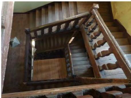
12, rue des Vierges. Escalier suspendu à trois volées et balustres carrés en poire (17<sup>e</sup> siècle). L'ouvrage remplace un escalier en vis du 15<sup>e</sup> siècle distribuant l'immeuble avant son remaniement
