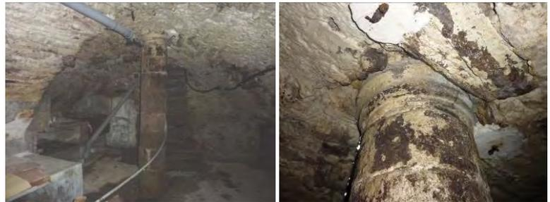
Place Henri IV. Cave sous voûte en berceau en maçonnerie de moellons, 15<sup>e</sup> siècle. Une colonne a été installée ultérieurement.
