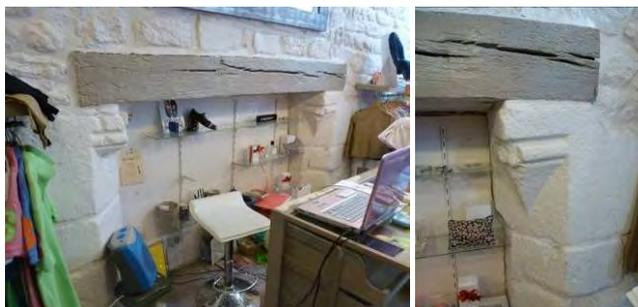
Rue des Halles. Cheminée de la seconde moitié du 15<sup>e</sup> siècle, à piédroits à consoles en forme de pyramide inversée, assurant le chauffage d'un ouvrier occupant le rez-de-chaussée de la maison.
