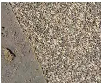
Le béton désactivé ou béton lavé :
